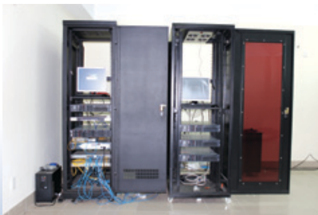
Hệ thống máy chủ và lưu trữ thông tin SAN
