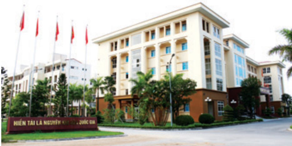
Khu nhà điều hành với các trang thiết bị hiện đại, môi trường xanh - sạch - đẹp
