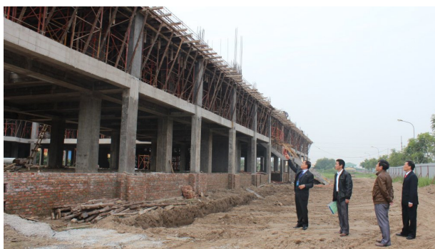
Đoàn kiểm tra thực tế khối lượng thi công của dự án Giảng đường thư viện
